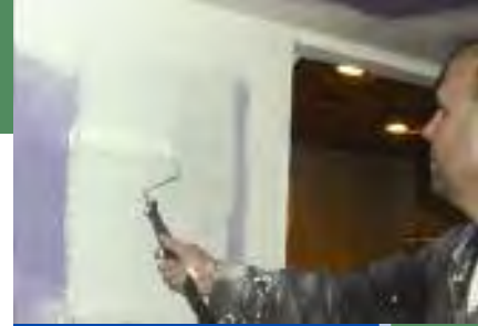
Applying primer to new drywall.
